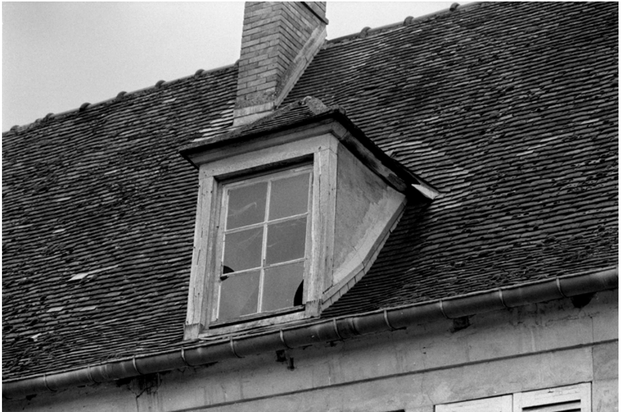
Détail de lucarnes.
