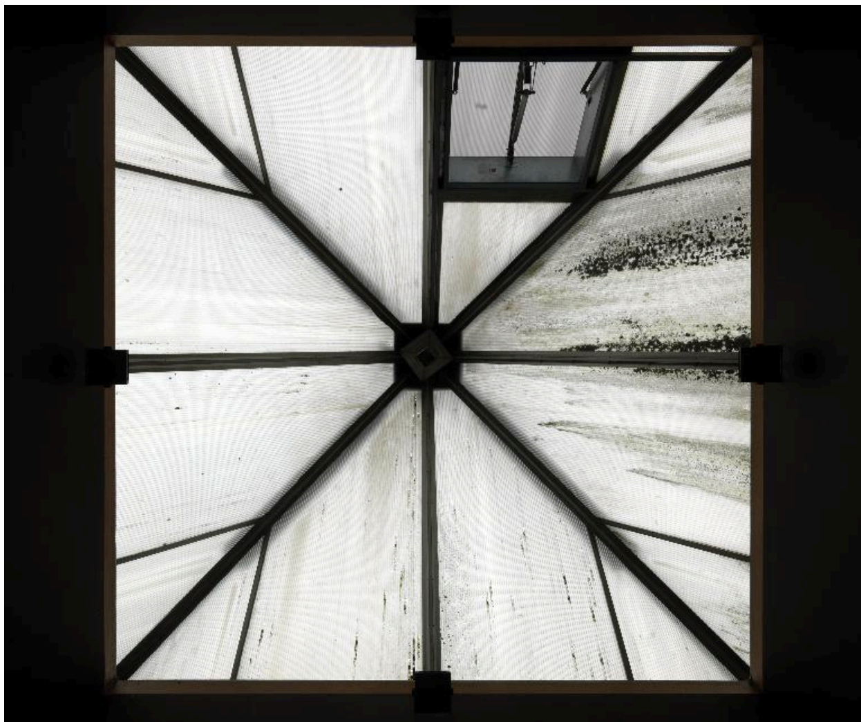
Vue intérieure de l'éclairage zénithal.
