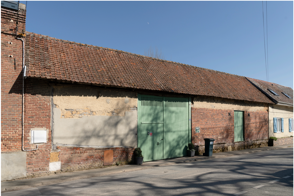
Grange sur rue, n°19 de la rue Yves-Maréchal, vue depuis l'ouest.
