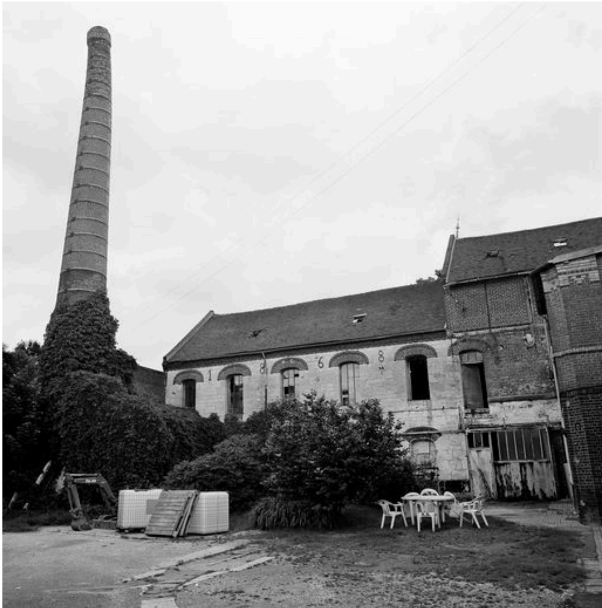
Atelier de fabrication principal, cheminée d'usine.
