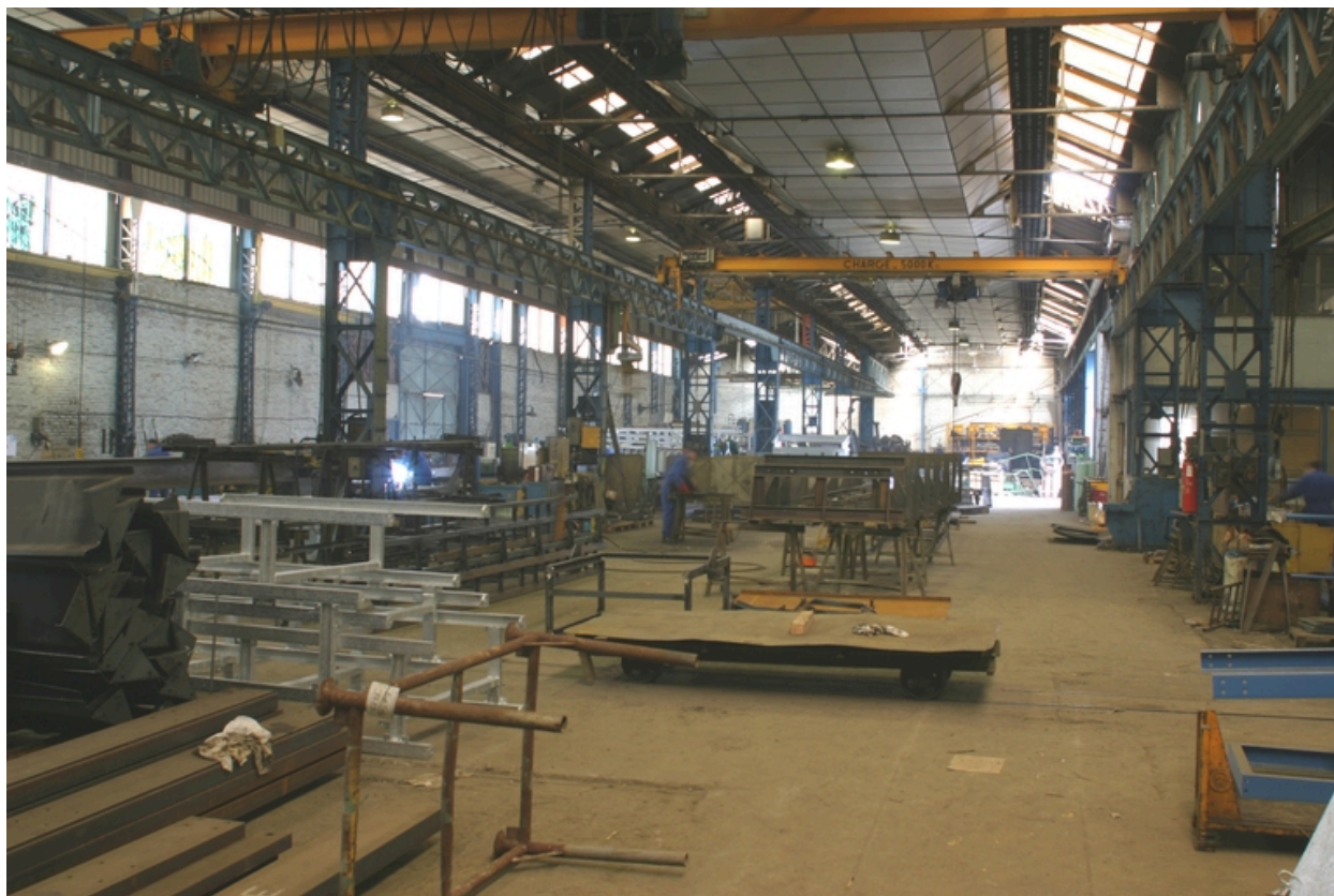
Ateliers : vue intérieure.
