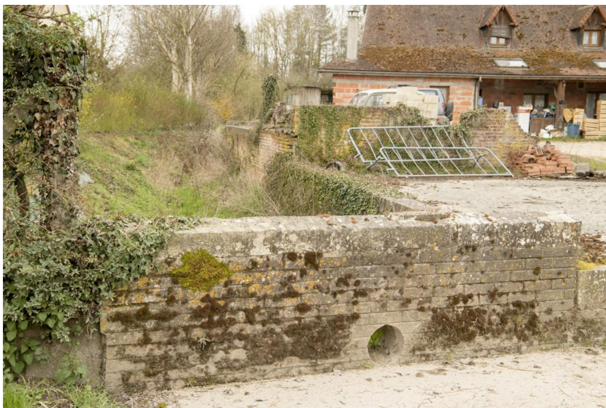
Ponceau, rue de Choqueuse.
