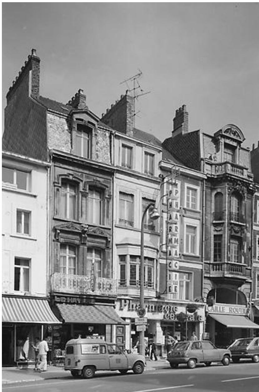
Vue générale sur voie.
