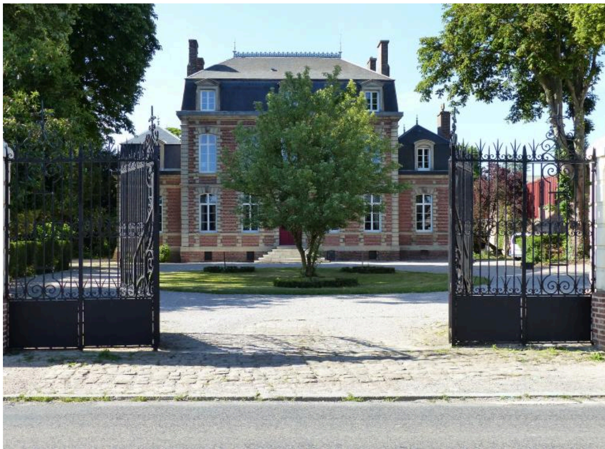
Vue de situation depuis la route.
