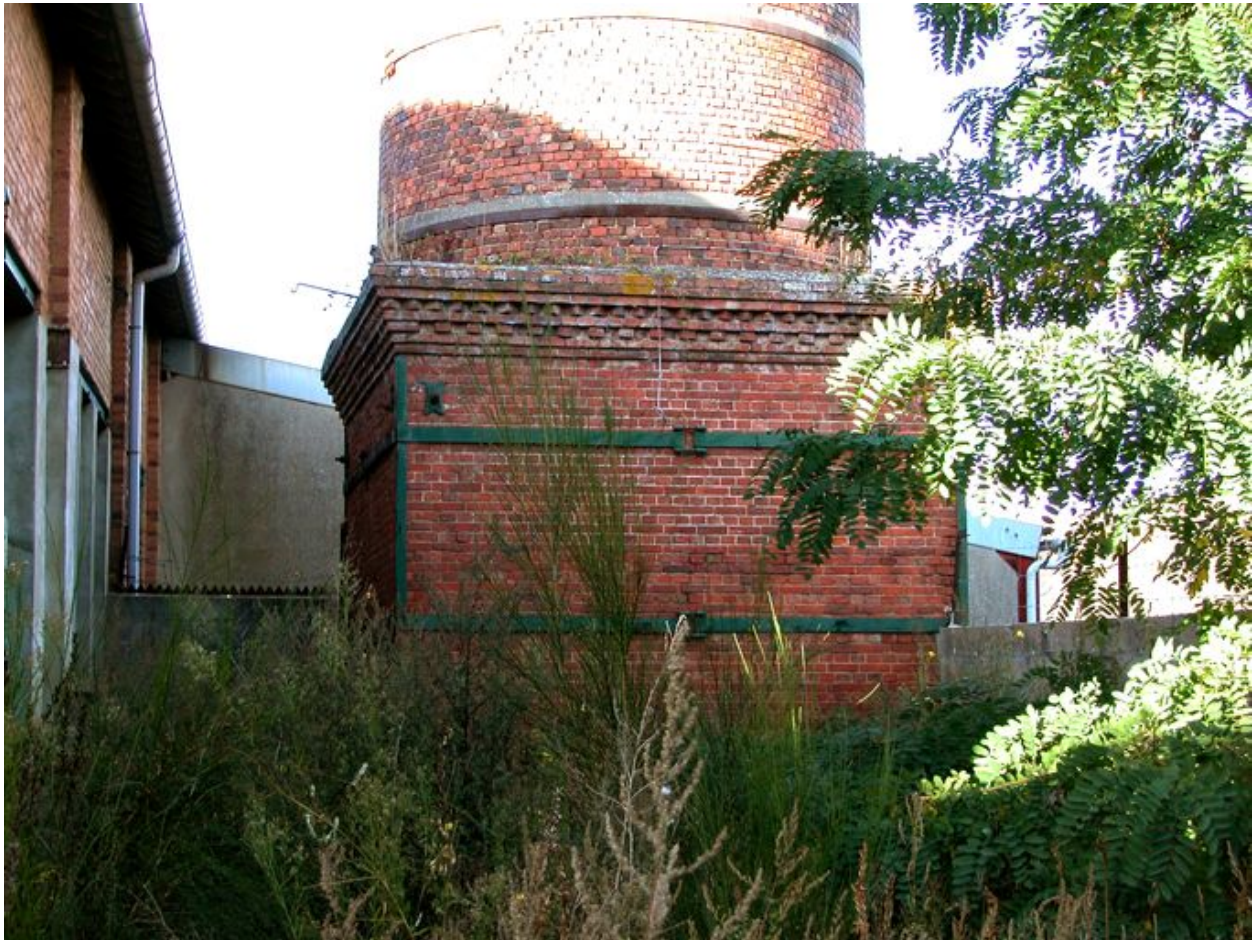
La base de la cheminée.
