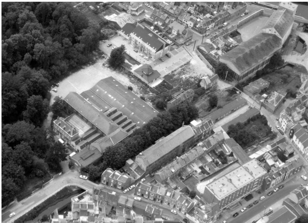
Vue aérienne, flanc nord-est.
