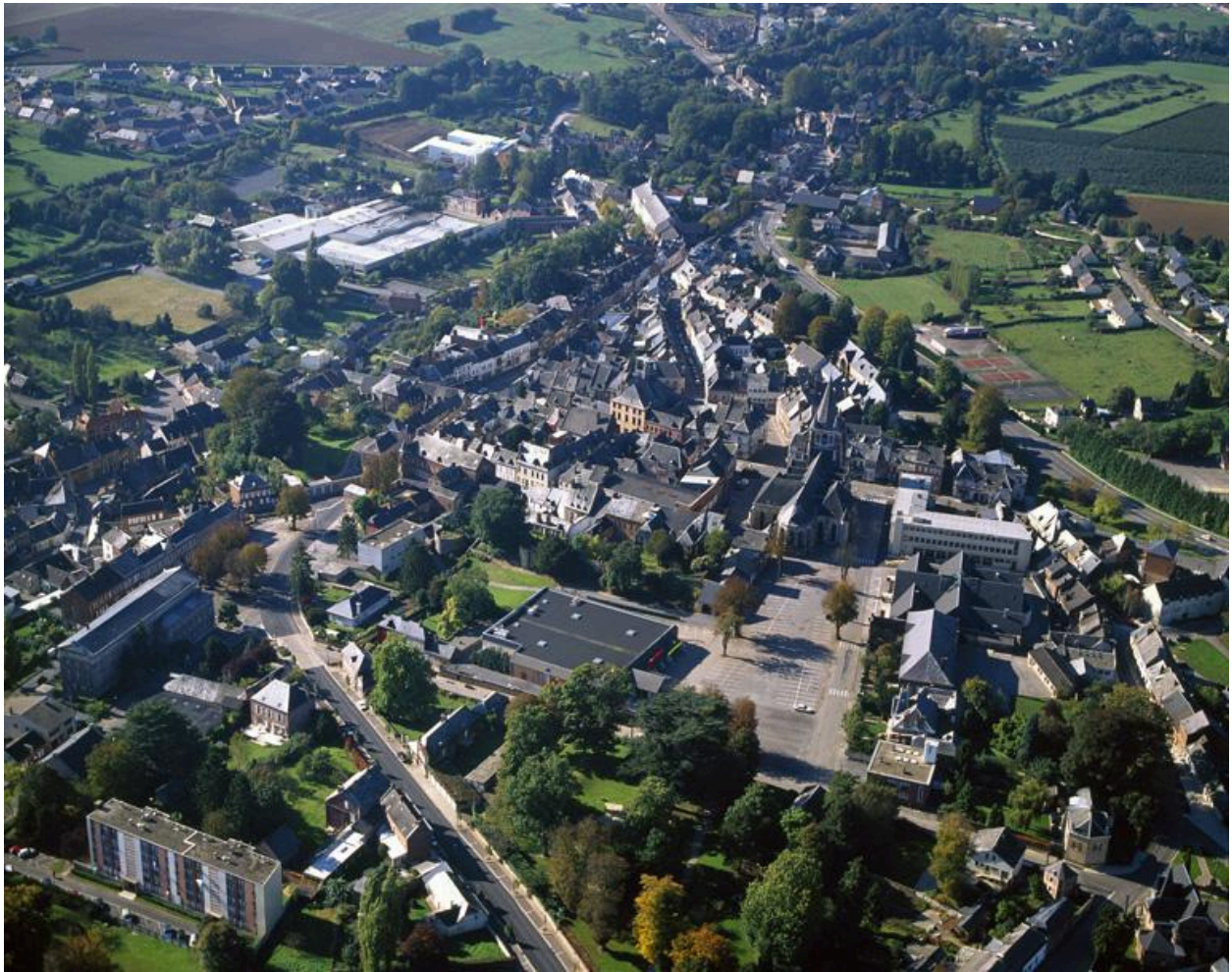
Vue générale, depuis l'est.
