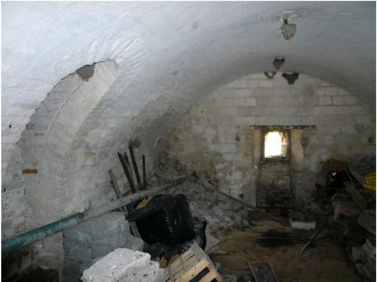
Vue de la cave du logis, en pierre de taille.
