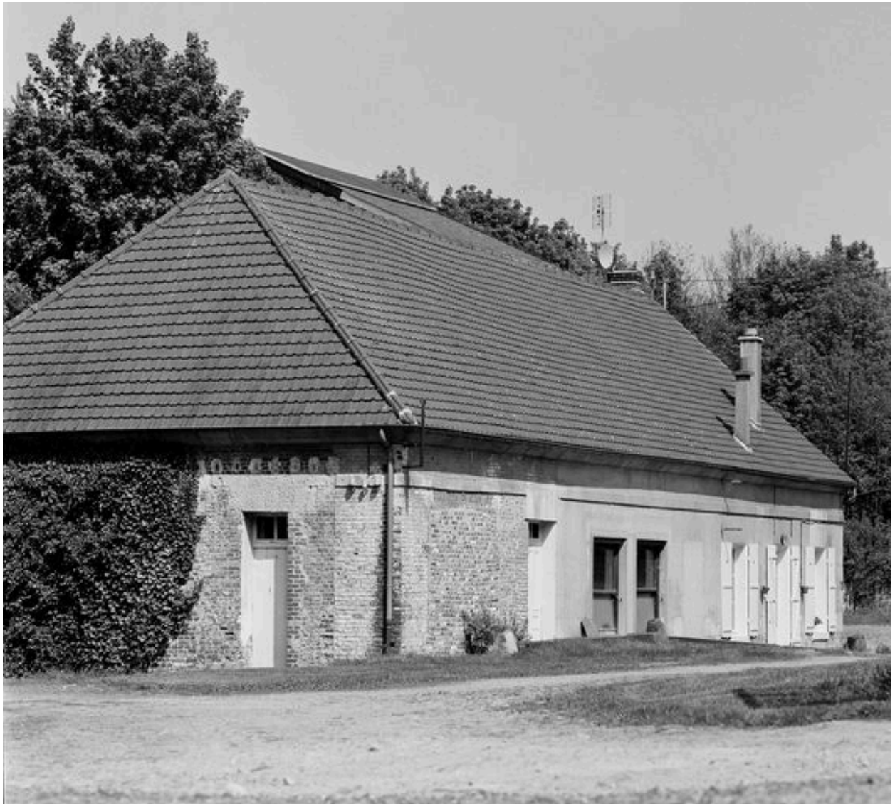
Bureau, façade nord.
