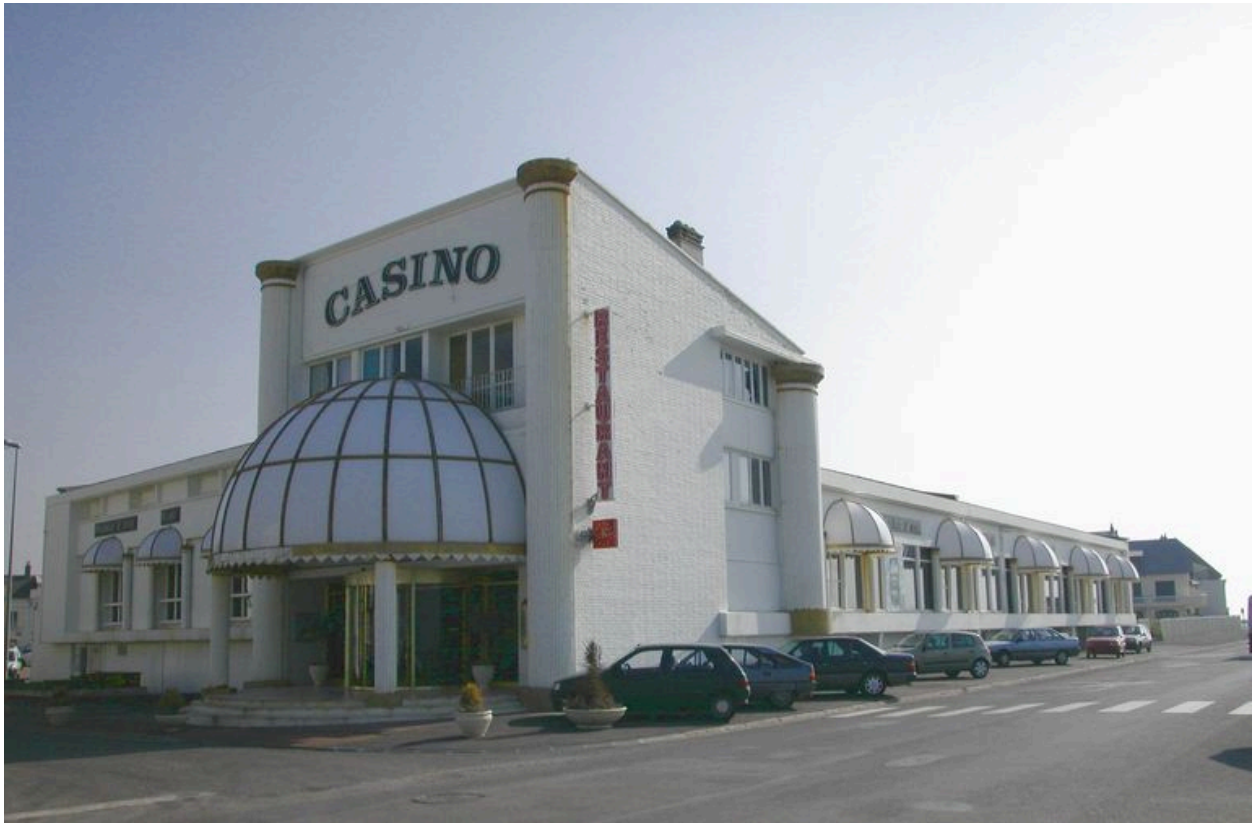
Vue d'ensemble sur la façade d'entrée et la façade sur mer, casino actuel.
