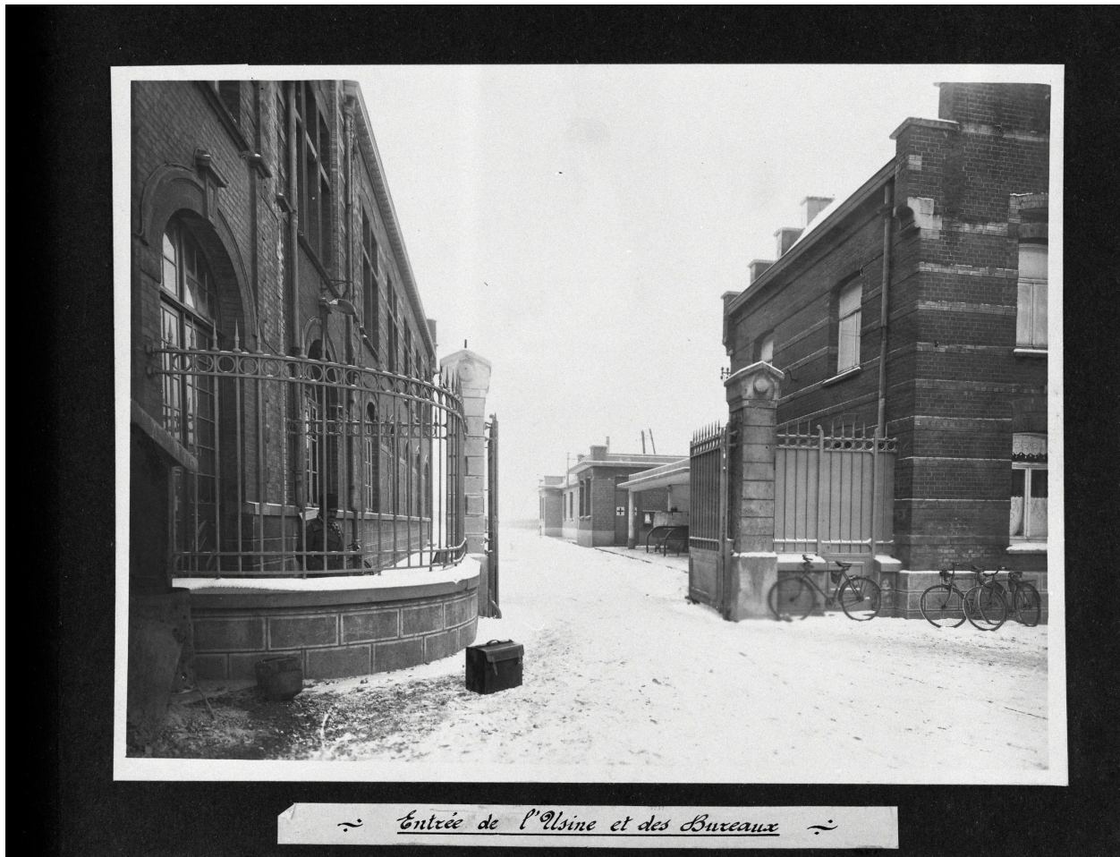
Entrée de l'usine et les bureaux, 16 février 1940. Photographe inconnu (coll. part., archives Cerec).
