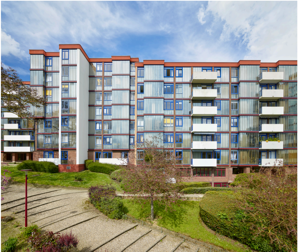
Vue du bâtiment E depuis le sud (toit-terrasse des garages).
