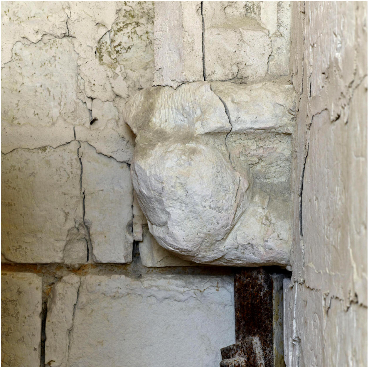
Détail d'un cul de lampe sculpté de la salle des gardes du beffroi.
