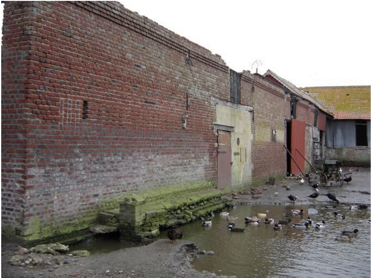
Vue des étables bordant le côté sud de la cour.
