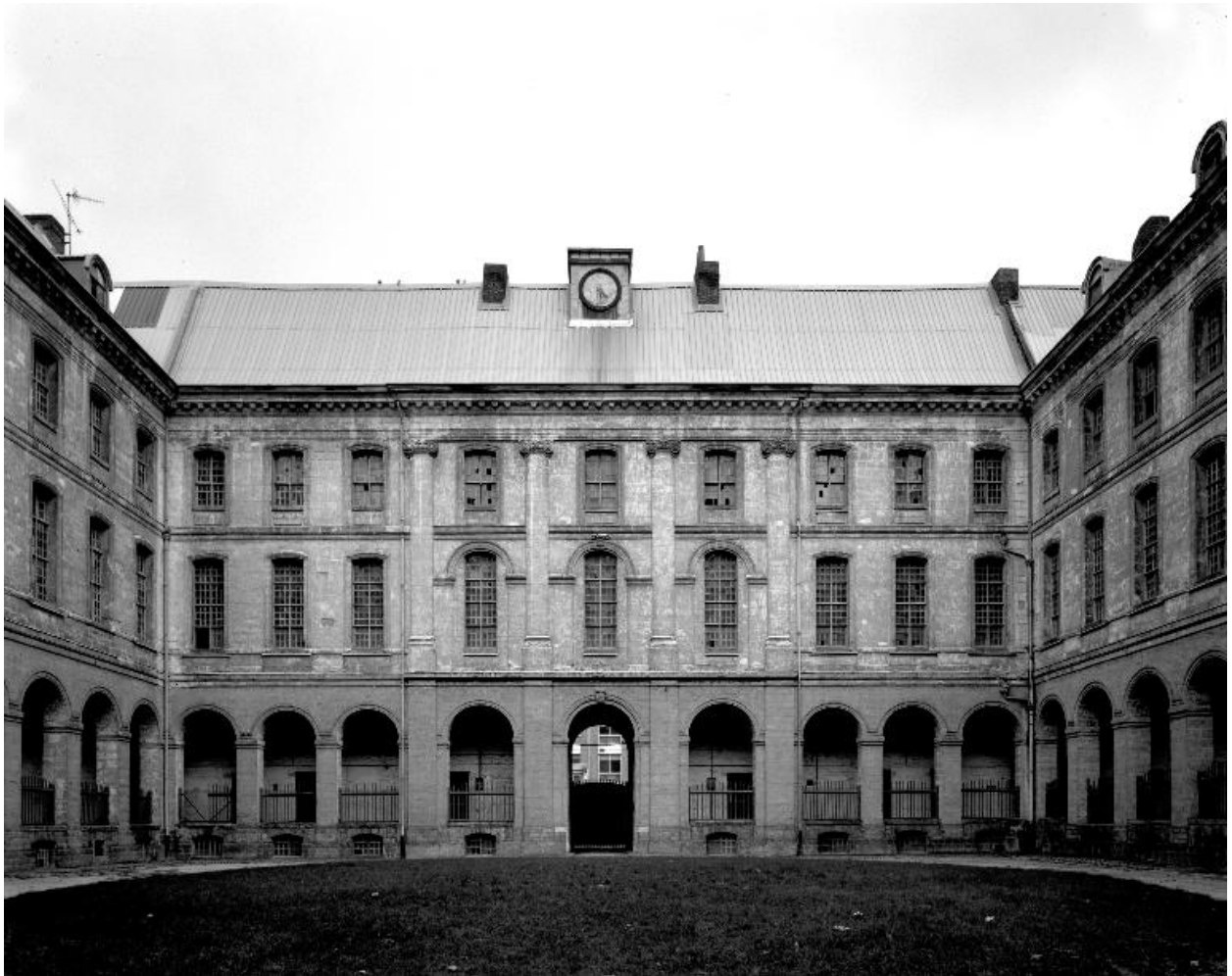
Cour d'honneur, élévation du bâtiment fermant le fond de la cour.
