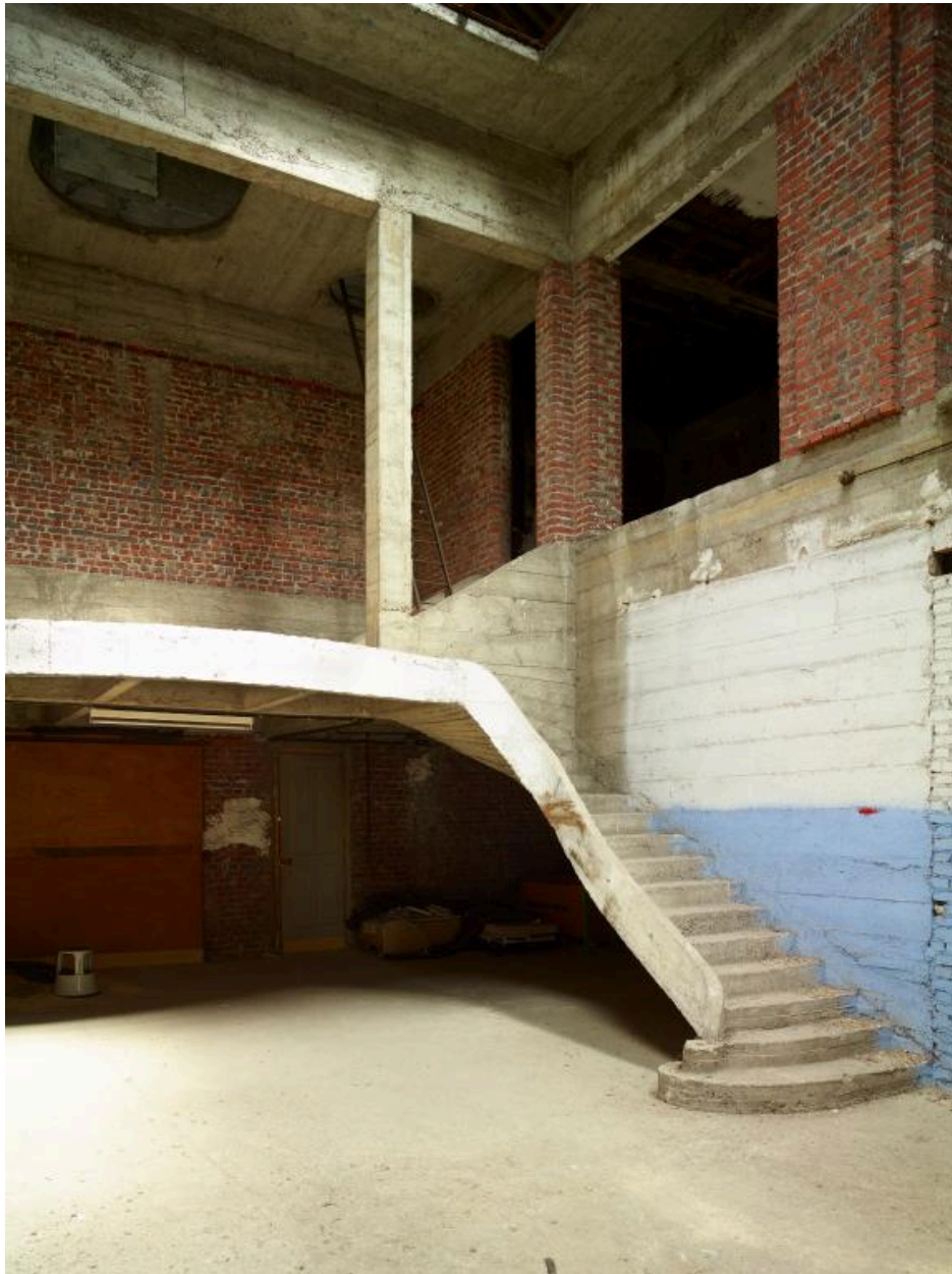
Ancienne cour à marchandises, vue partielle de l'escalier de droite.
