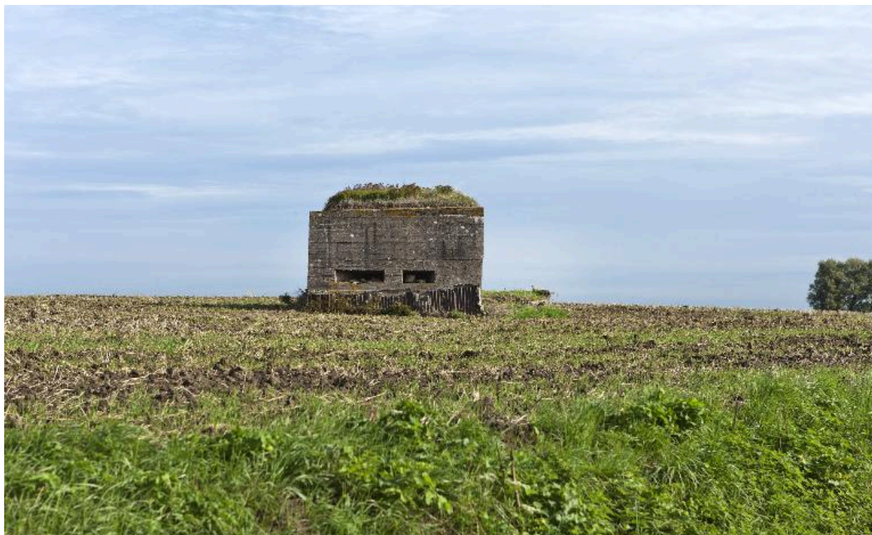
Elévation sud depuis la route
