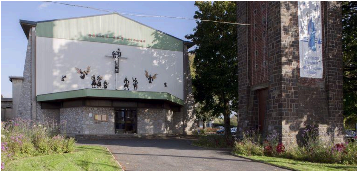
Vue de trois quarts gauche de l'élévation antérieure.
