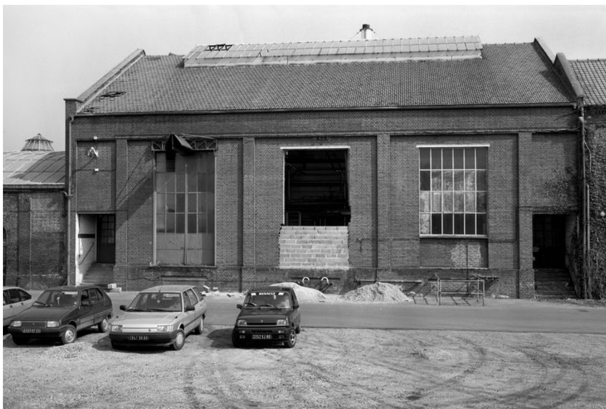
Chaufferie, état en 1988.
