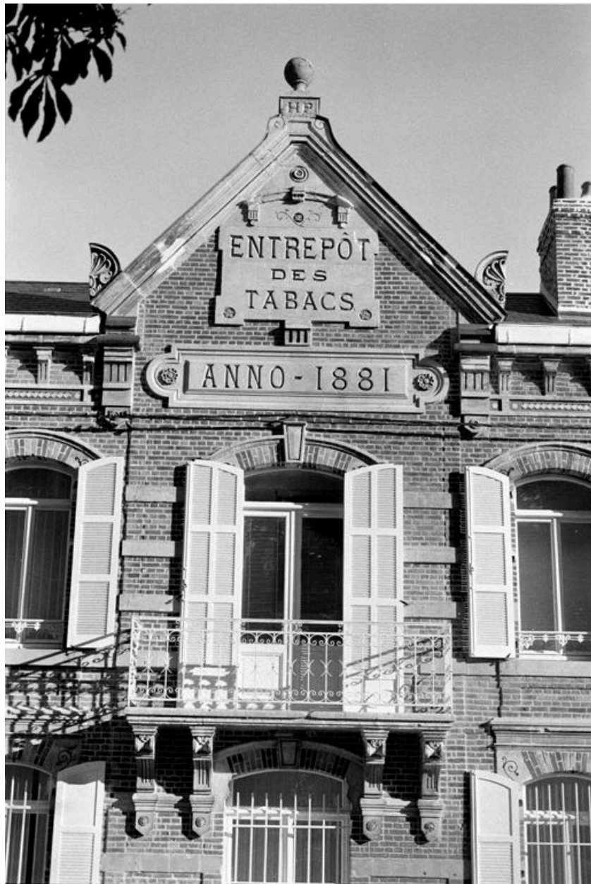
Vue du fronton de la façade principale.
