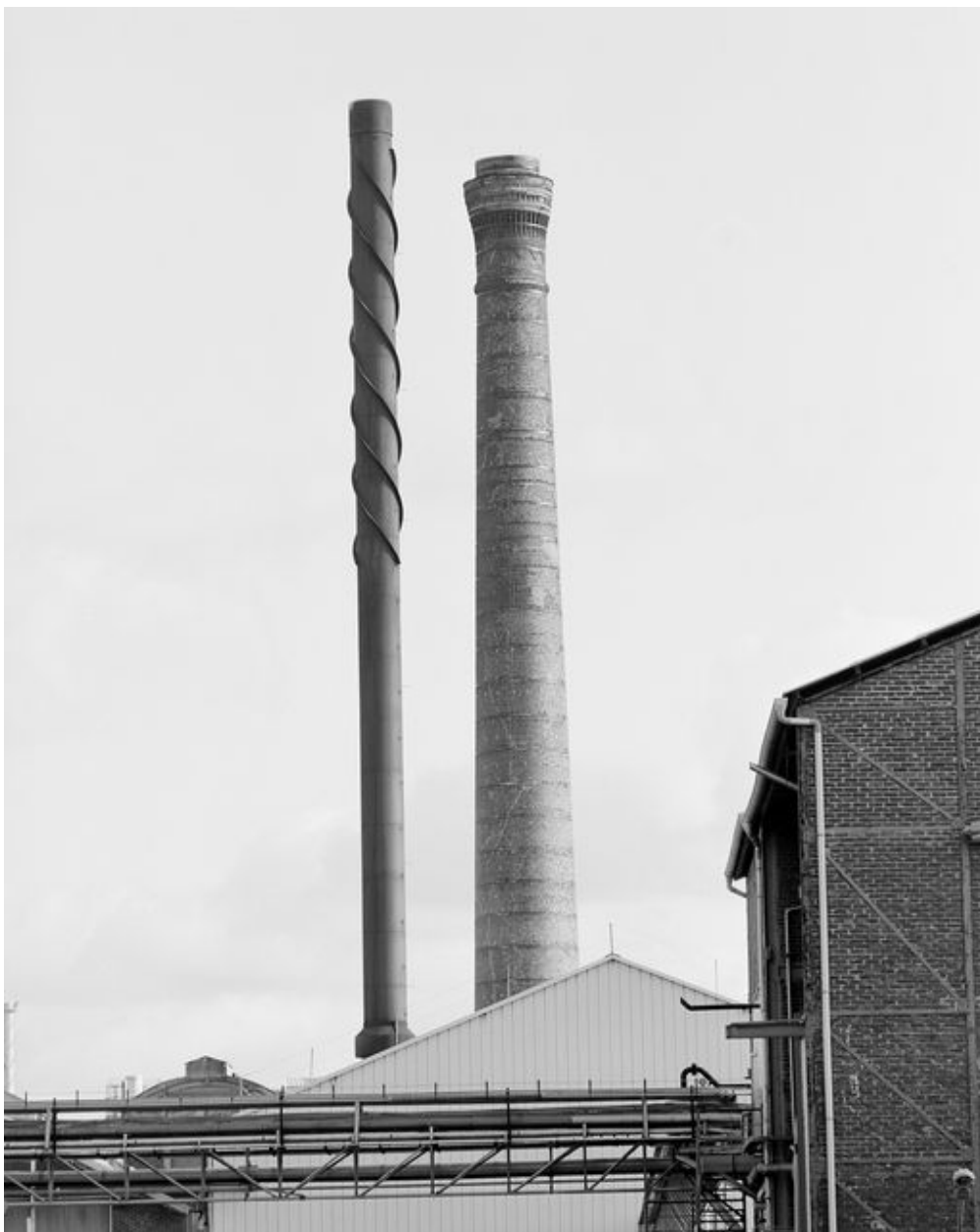
Cheminée d'usine construite en 1897.
