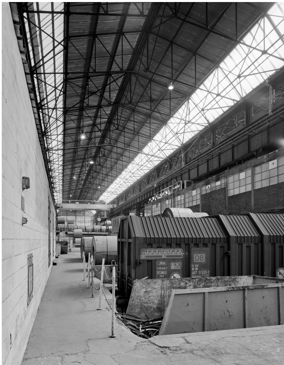
Vue générale de la halle de stockage des bobines non traitées.
