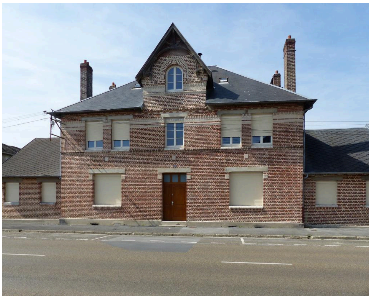
Vue du logis sur rue.
