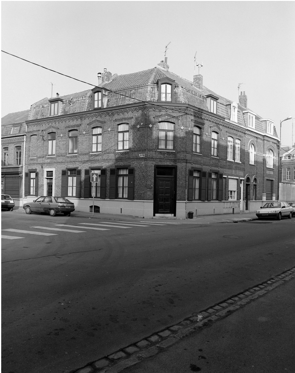
Vue générale sur angle.
