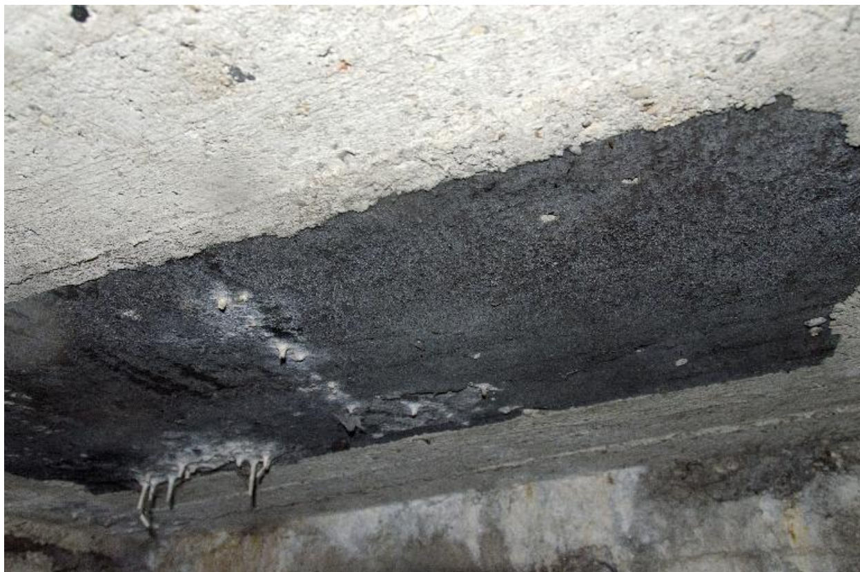
Salle S8, plaque métallique au plafond
