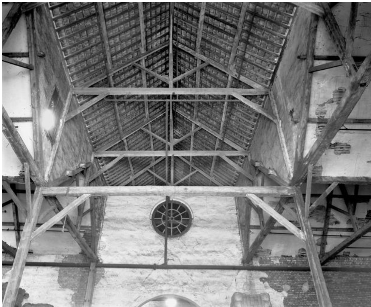
Intérieur de l'entrepôt à jute, état en 1988.
