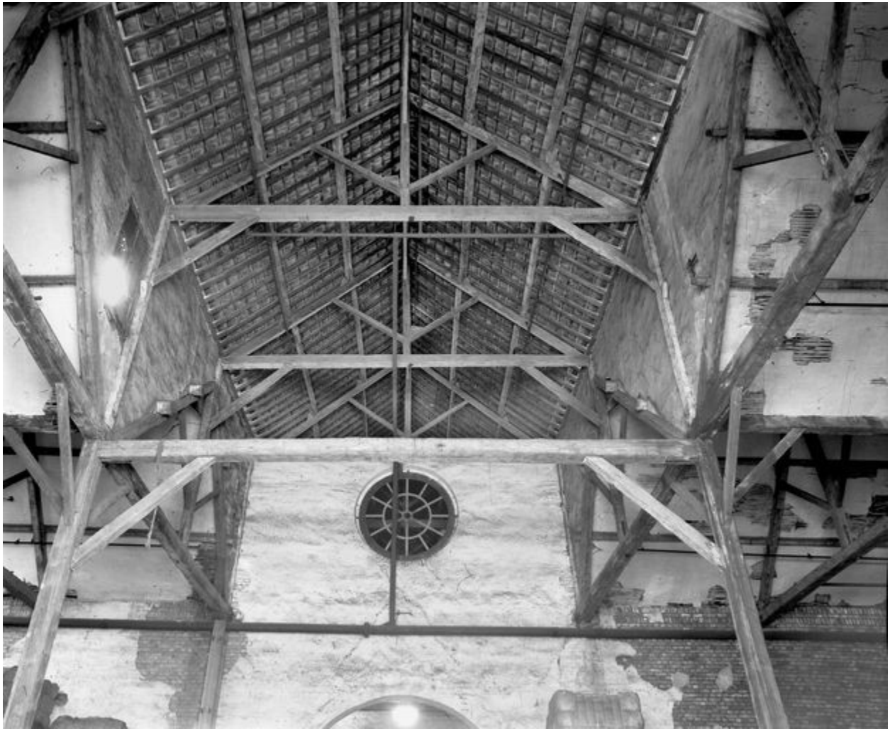
Intérieur de l'entrepôt à jute, état en 1988.
