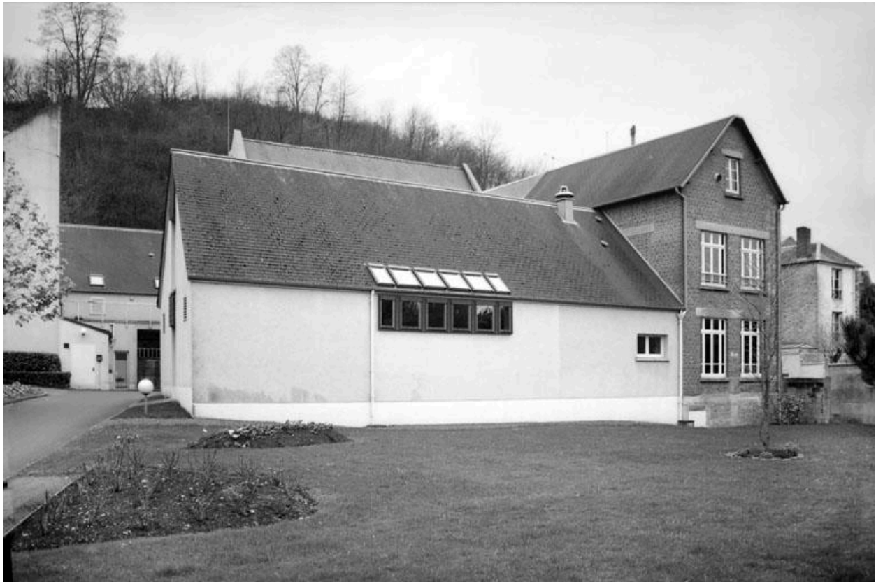
Vue des bâtiments, depuis l'arrière.
