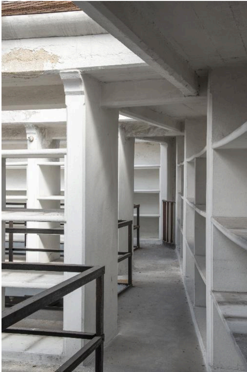
Bâtiment du dépôt, troisième étage : vue des rayonnages du côté est et de l'extrémité des vaisseaux 1 et 2.
