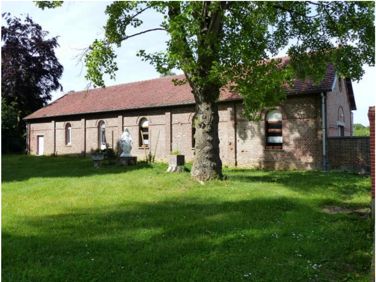
Vue depuis le nord-est.
