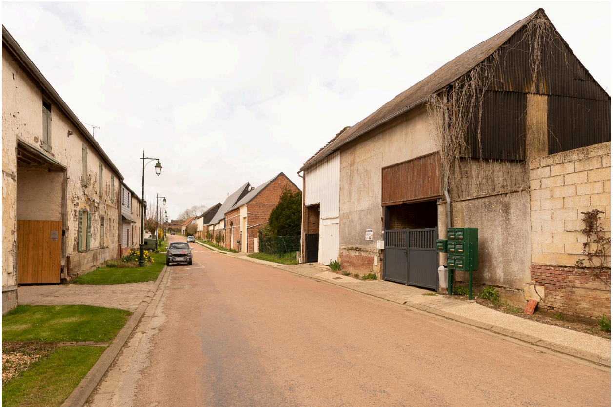
La Neuve-Rue, vue générale vers l'ouest.
