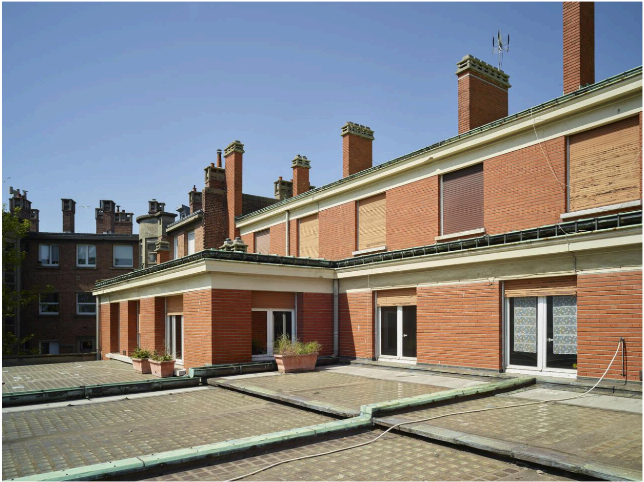
Vue de la façade sur cour et de la verrière du hall d'accueil.
