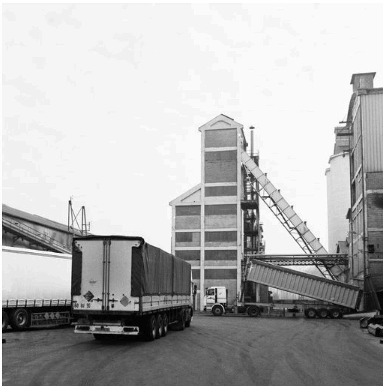
Atelier de fabrication : flanc ouest.
