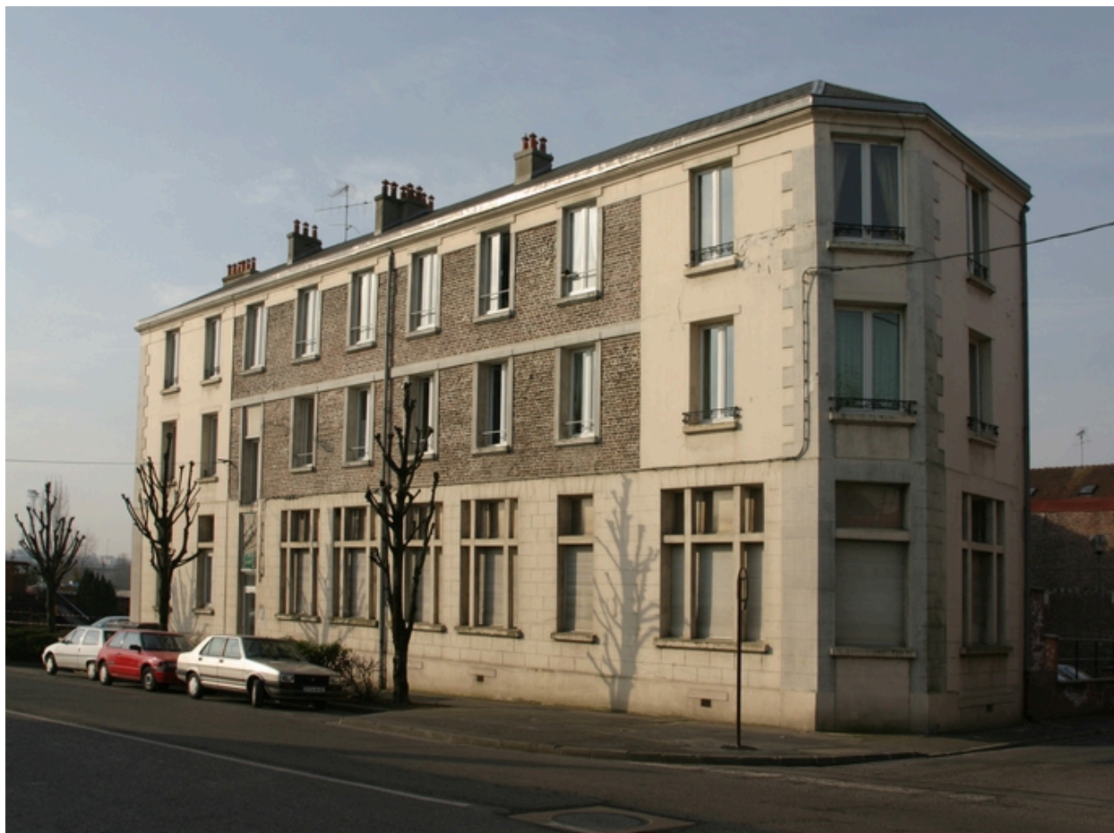
Façade antérieure de l'ancien tissage.
