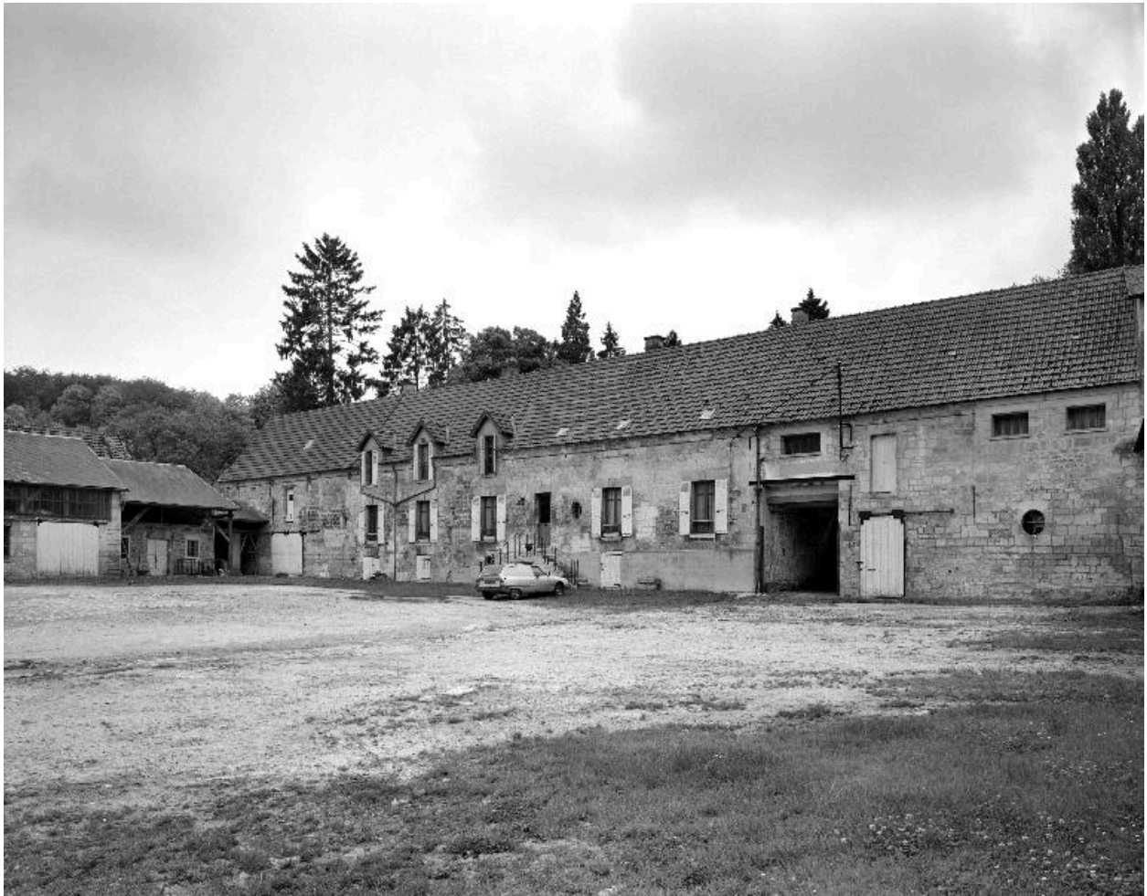
Ferme, rue du Moncet : vue des bâtiments qui bordent la cour au sud et à l'ouest.
