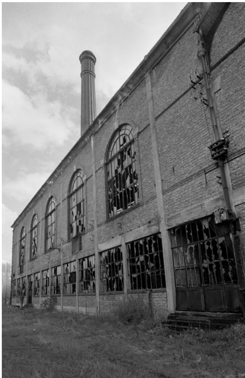
Centrale thermique, en 1983 : flanc nord (Ecomusée du Beauvaisis).
