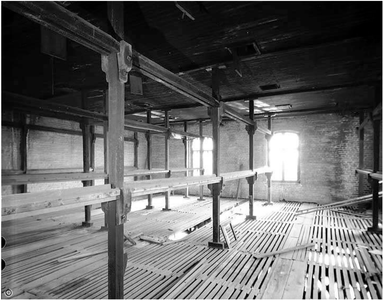
Pièce de séchage dite séchoir au feu (D) avec son plancher à claire-voie.
