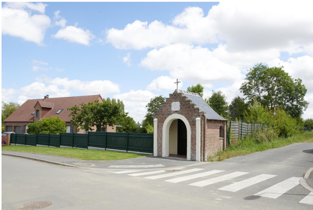
Vue générale de la chapelle.
