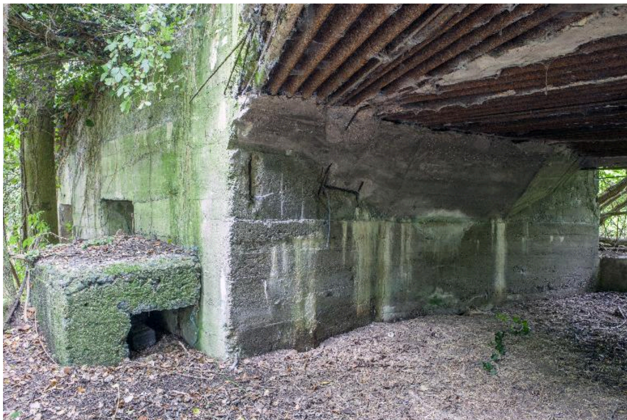
Profil sud de la chambre de tir
