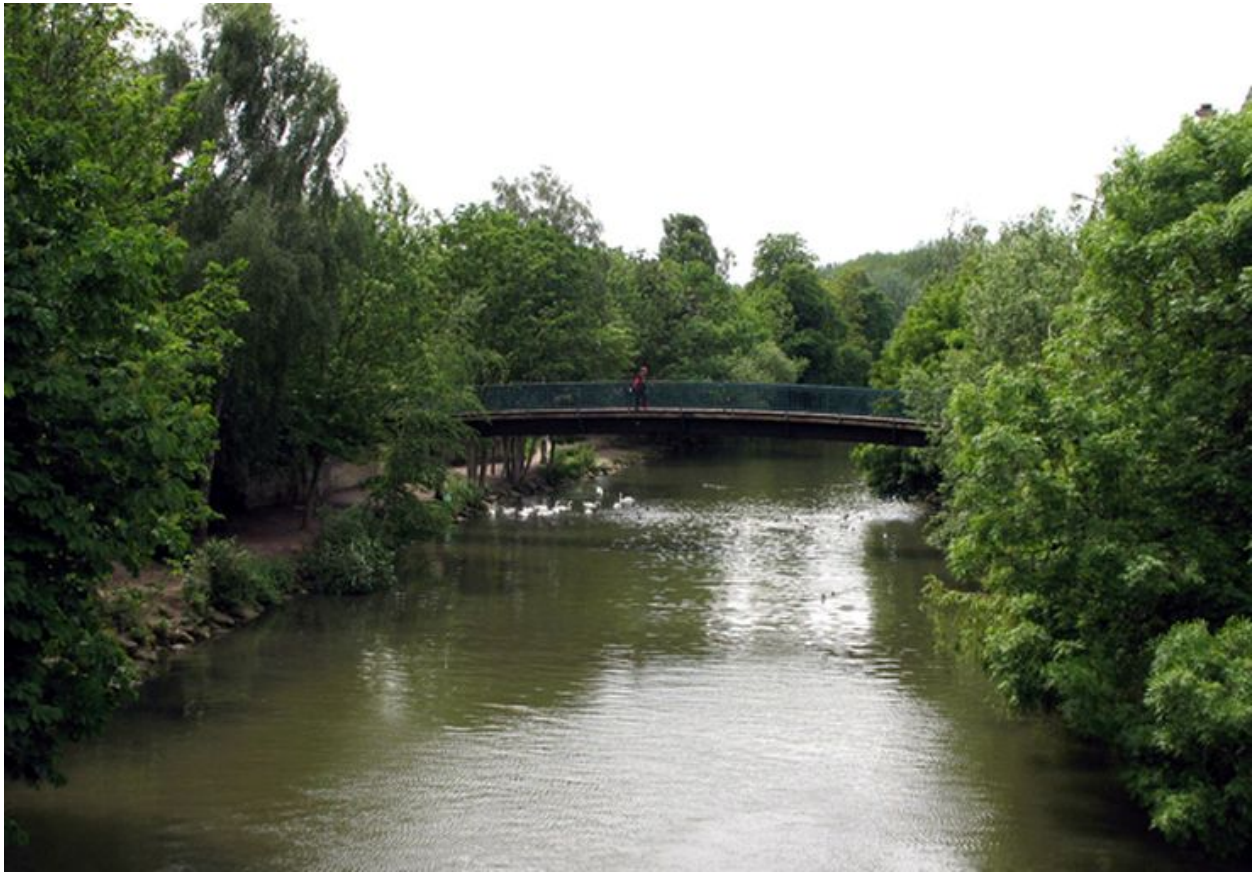
Passerelle construite sur le petit bras de l'Oise à l'emplacement du moulin.
