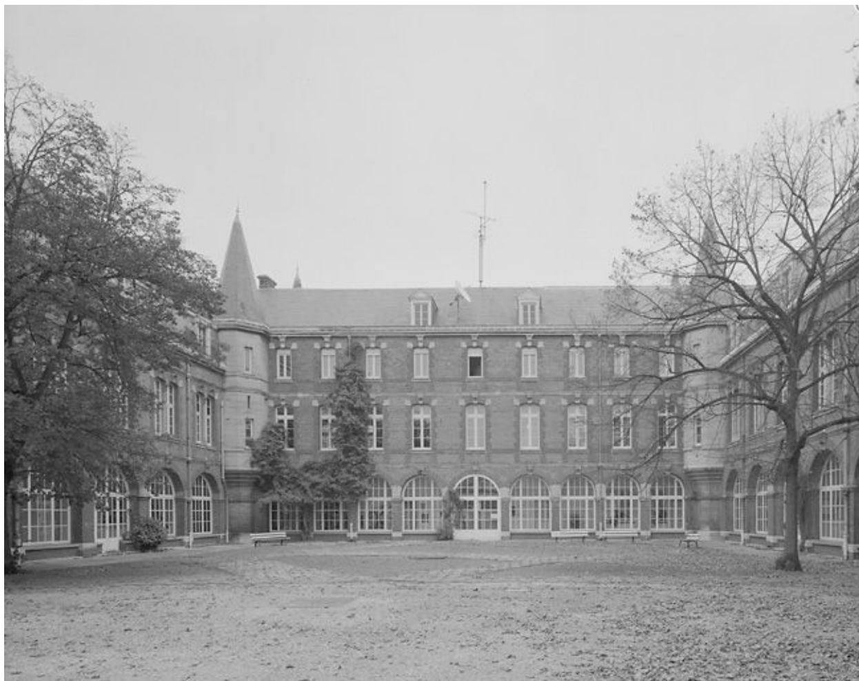
Façade postérieure sur la cour.
