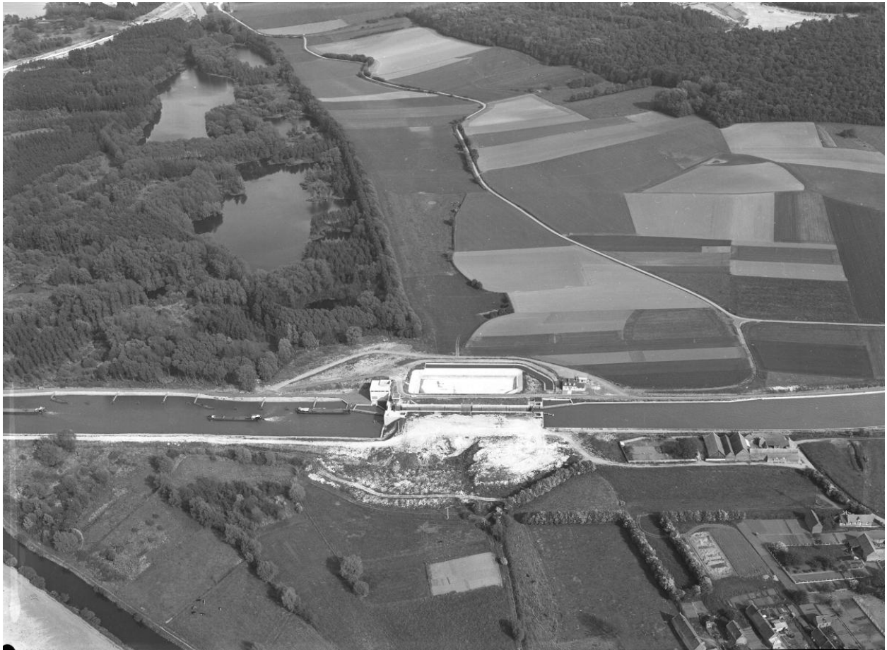
Vue aérienne du chantier dans le secteur de l'écluse n°1 de Palluel (Pas-de-Calais) en 1967. (IGN. Photothèque Nationale. 1967).
