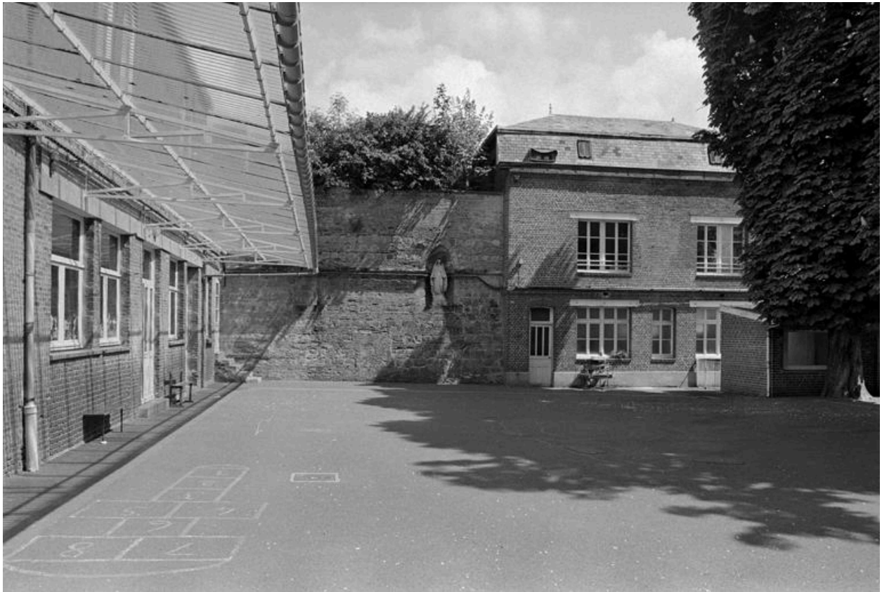
Vue de la cour, avec l'ancien préau à gauche et la fortification d'agglomération au fond.
