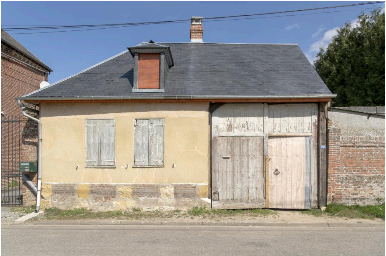
Façade de logis et entrée charretière sur rue (ancienne maison de serger?), n°22 rue Principale, vue depuis l'ouest.
