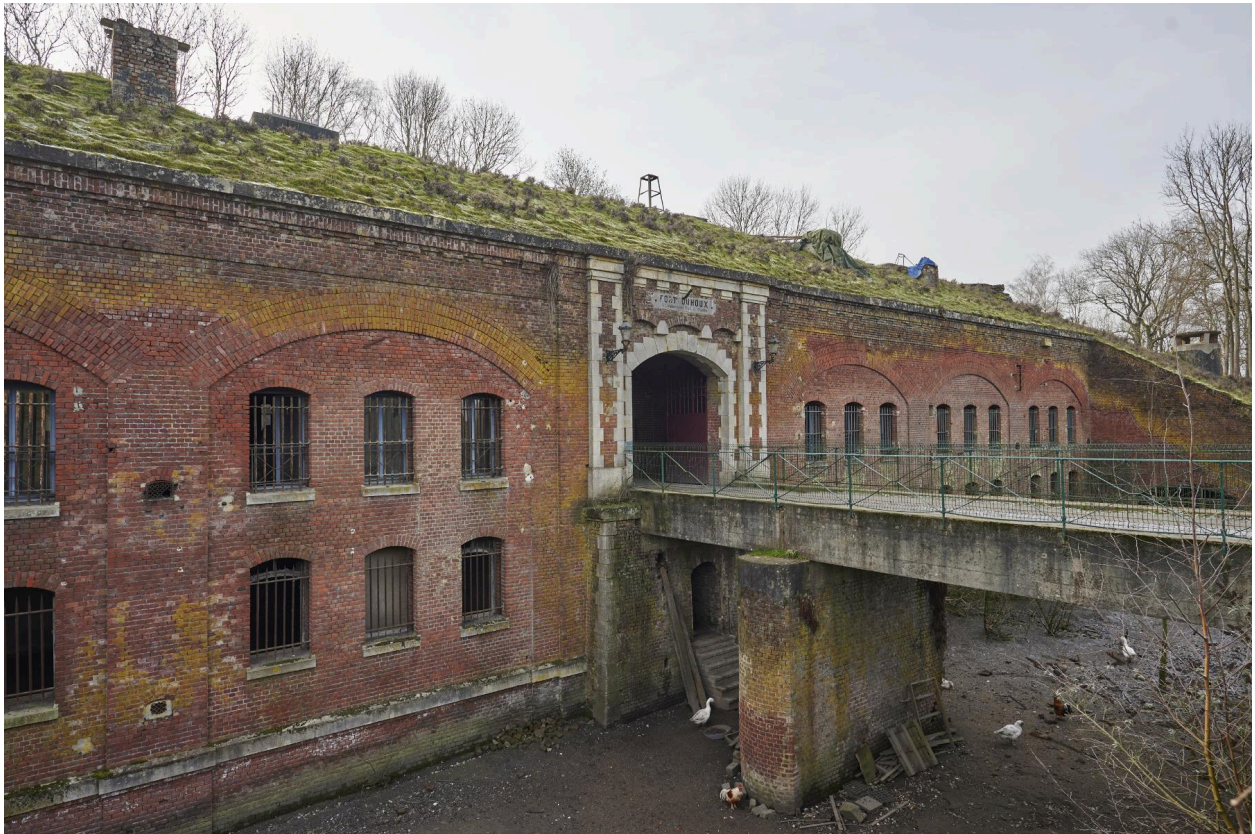
Élévation nord, caserne de gorge, pont dormant et (ancien) pont mobile, vers l'est.
