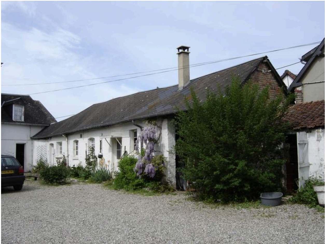
Vue des bâtiments agricoles situés à l'est de la cour.
